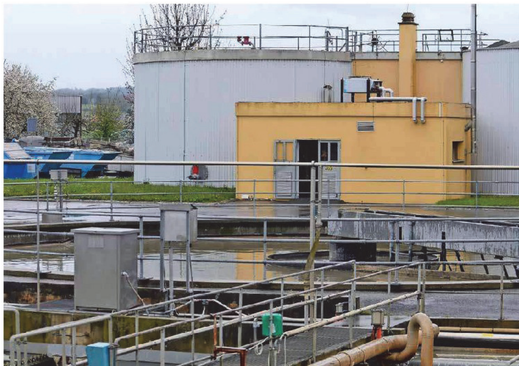
La STEP régionale sera construite à proximité des installations actuelles de Payerne. Vincent Murith-archives
