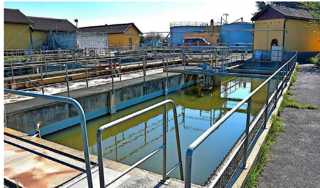
Quand la nouvelle STEP régionale sera opérationnelle, la STEP de Payerne sera transformée en station de pompage.
